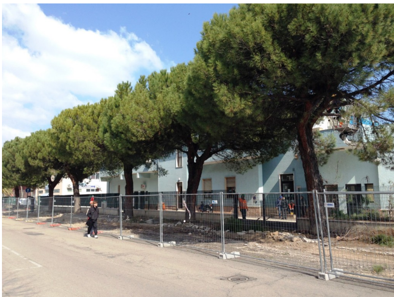
Lavori pista ciclabile Giulianova PRIMA
