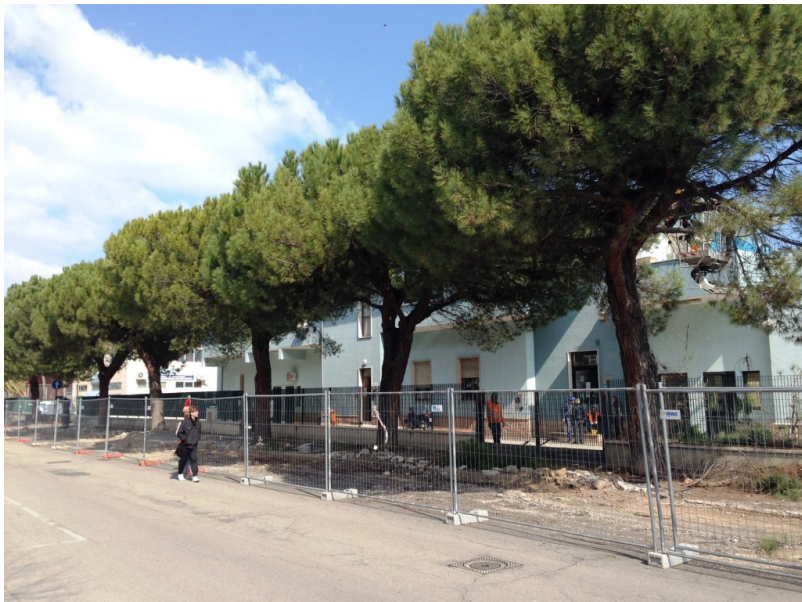
Lavori pista ciclabile Giulianova PRIMA
